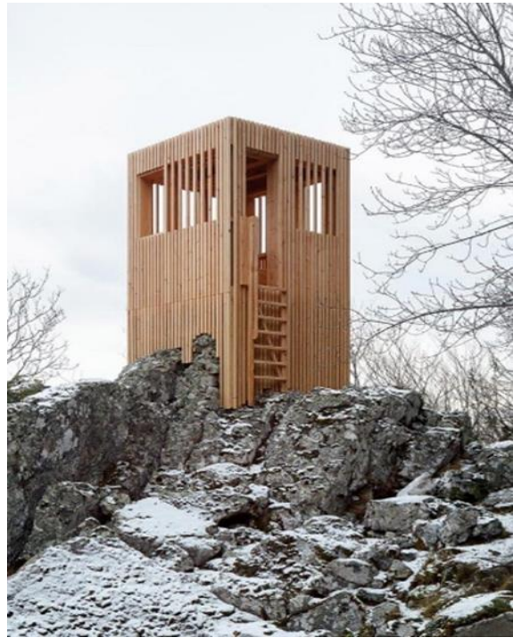
Observatoire du cerf en Corse https://www.orma-architettura.com/projets/observatoire-cerf-corse
